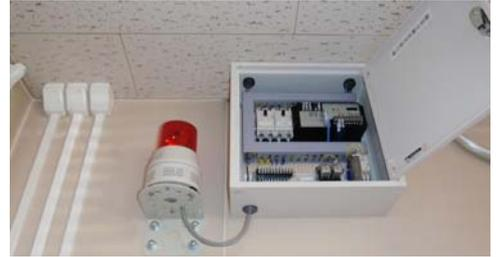
市内の公共施設(52箇所)にデマンド監視装置及び通信装置を設置。
